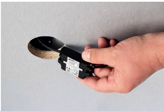
3 - Kompaktes Netzgerät wird in den Hohlraum eingeschoben
