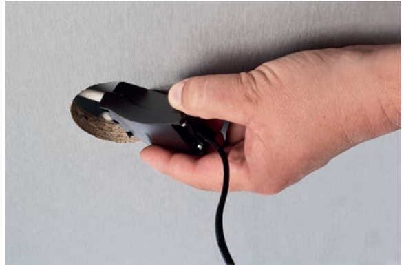
2 - Quick-Anschlussbox wird über den 68-mm-Ausschnitt im Hohlraum platziert
