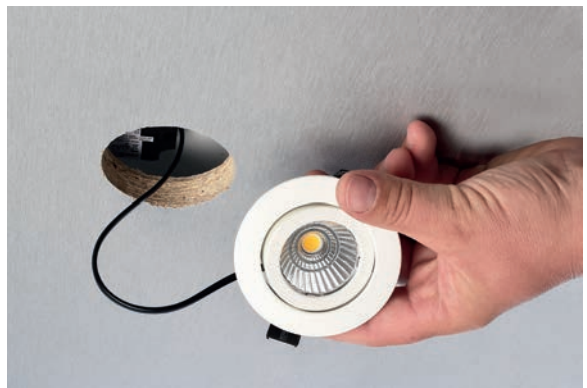
4 - Einsetzen des Spots in den Deckenausschnitt
