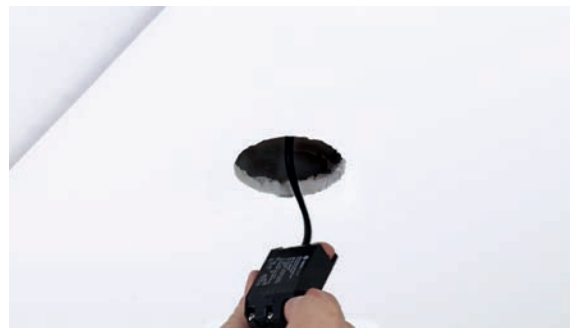
3 - Kompaktes Netzgerät wird in den Hohlraum eingeschoben
